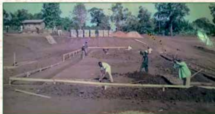
Lancement des travaux sur le site (2002)
